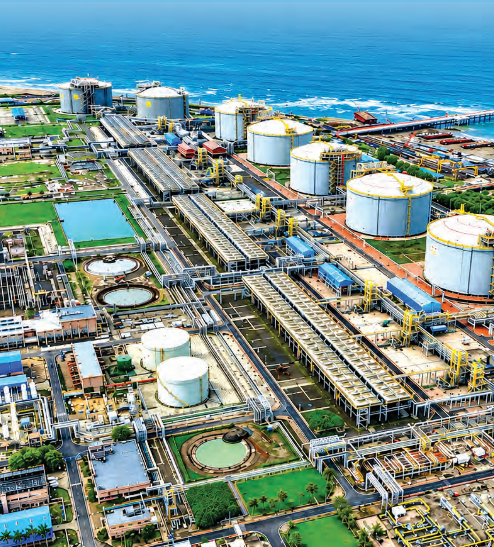
*Aerial view of Dahej LNG Terminal
