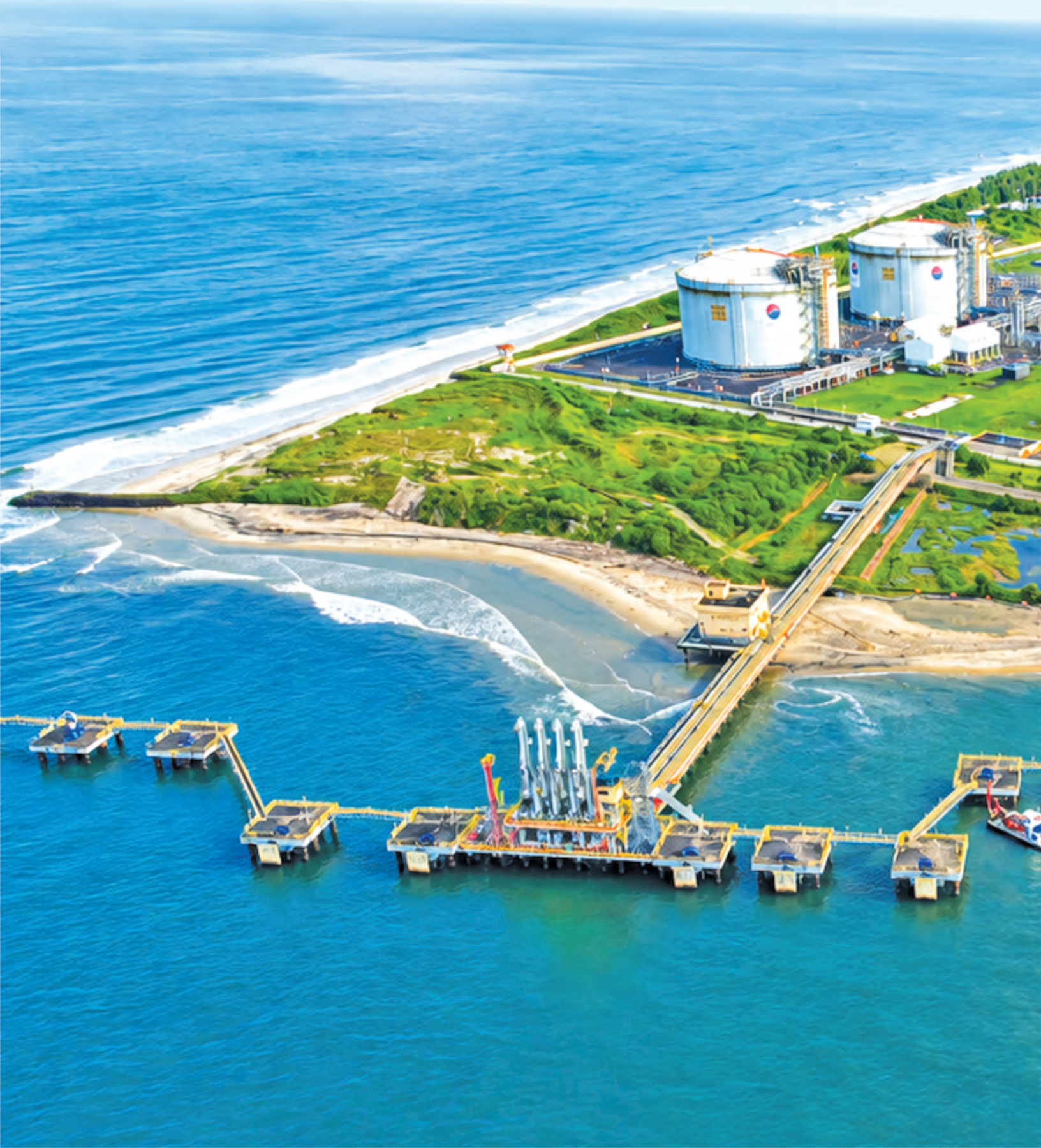
Aerial view of Kochi LNG Terminal
